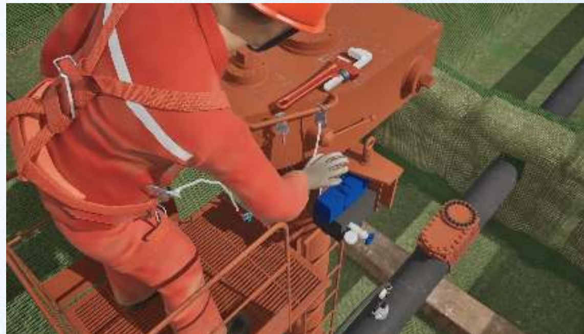
输油管线带压封堵实训过程
